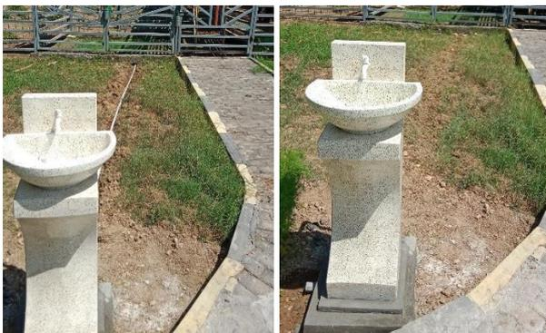
Untuk pemasangan tempat cuci tangan yang agak jauh dengan sumber air, maka diperlukan tambahan instalasi pipa air.
