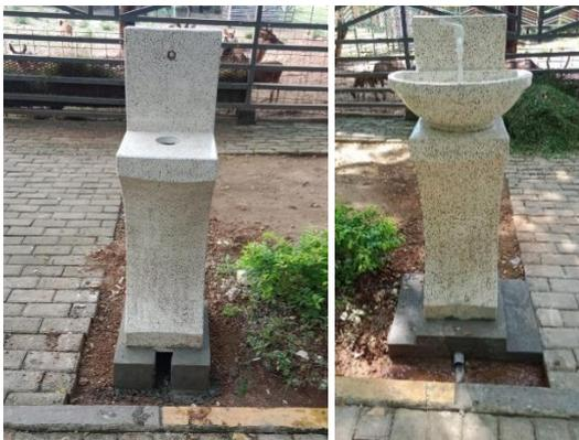
Pemasangan tempat cuci tangan yang dilakukan dengan penyemenan sebagai dasar tempat cuci tangan dan instalasi pipa pembuangan.
