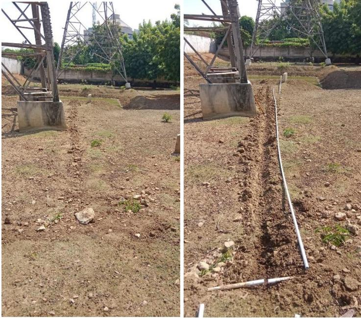
(Gambar samping) Area kandang dalam yang pada musim penghujan mengalami genangan, maka dipasang instalasi pipa yang ditanam didalam tanah agar tidak mengganggu gerak aktifitas rusa
