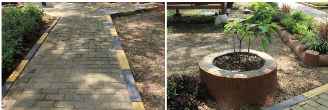
Gambar 10 Gambar Pengecatan Pot dan Tepian Paving
