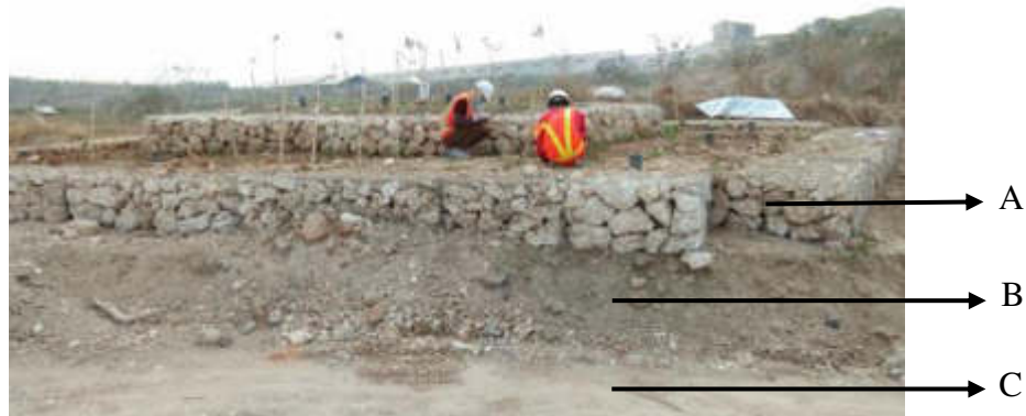
Gambar 2.2 Unit framework terasering lahan bekas tambang batu kapur dengan lapisan basal di kawasan PT Semen Indonesia (Persero) Tbk. (Sumber: Laporan Akhir Penelitian PKPT, 2019)
