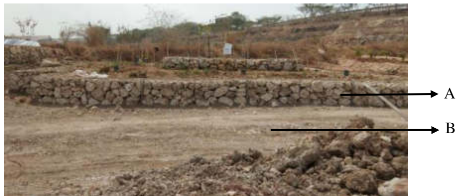
Gambar 2.1 Unit framework terasering lahan bekas tambang batu kapur tanpa lapisan basal di kawasan PT Semen Indonesia (Persero) Tbk. (Sumber: Laporan Akhir Penelitian PKPT, 2019)
